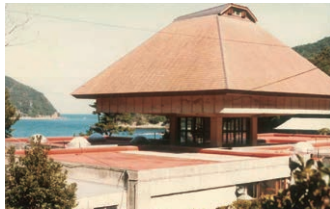
1970年代の本館塔屋と屋上
