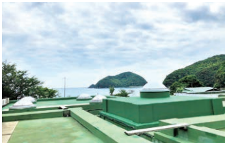
新しい本館屋上
